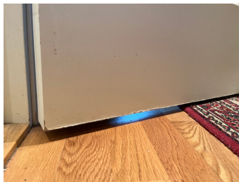
Dør til bad har skade i nedkant.
