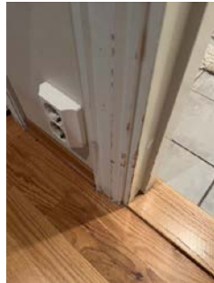
Dør til bad har skade i nedkant.
