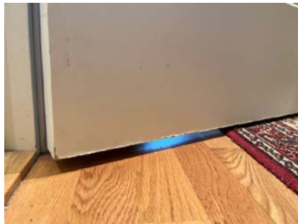
Dør til bad har skade i nedkant.
