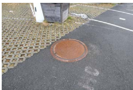
Kum for pumpeanlegg avløpsvann.
