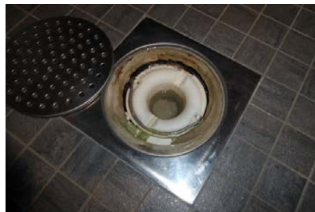
Sluk med vannlås.
