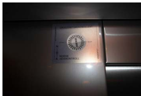
Bildet viser skilt med gjennomført kontrollpåskrift.
