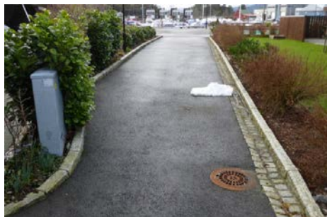
Renne langs kantstein som fører til overvannssluk.
