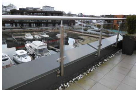
Bildet viser rekkverkløsning, dreneringsrenne og flistekking 3. etg.
