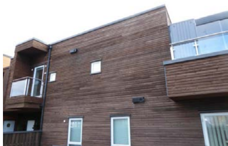
Panelkledning med MøreRoyal 2-trinns behandling.
