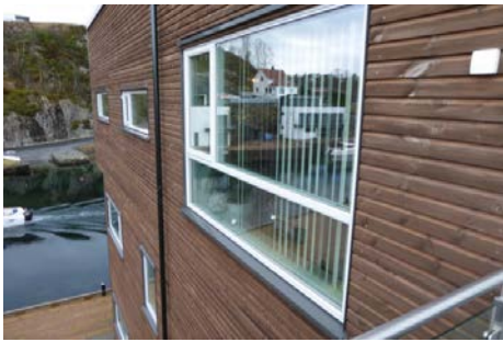
Vinduer med utvendig aluminiumskledning.
