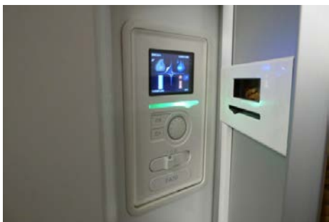
Styringspanel på avtrekksvarmepumpa.
