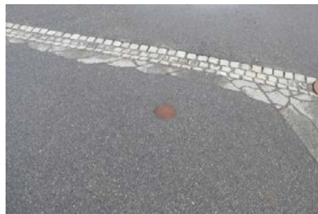
Renne mot overvannssluk.
