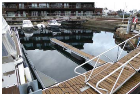
Utriggere - gangbar til høyre og enkel til venstre.
