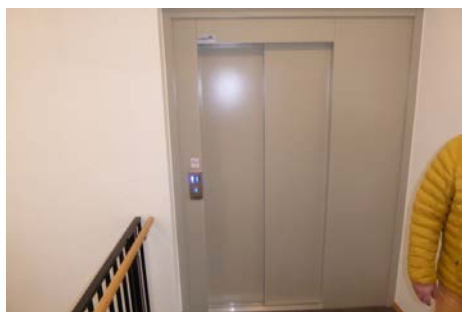
Bildet viser heisdør i oppgang.
