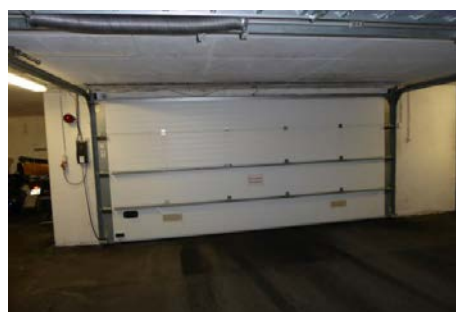
Garasjeport sett fra innsiden.
