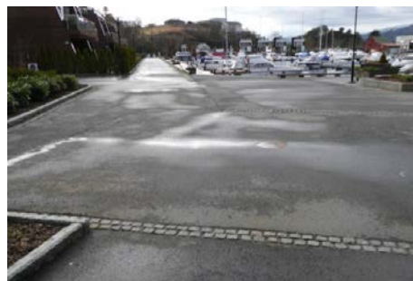
Oversiktsbilde som viser flere overvannssluk og renne.
