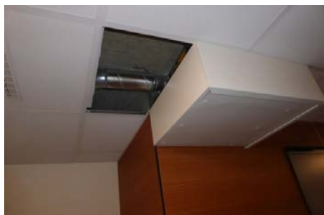
Plassering av adsorpsjonsavfukter i fellesarealer Kompasset.
