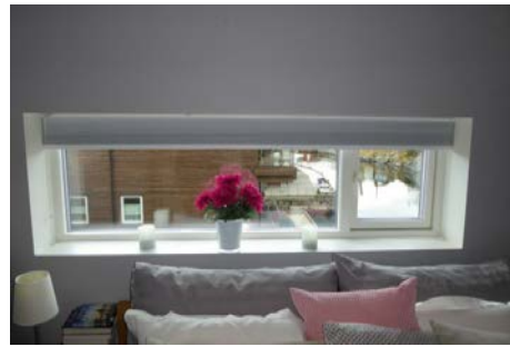
Innvendig fôrings- og listefri avslutning mot vegg.
