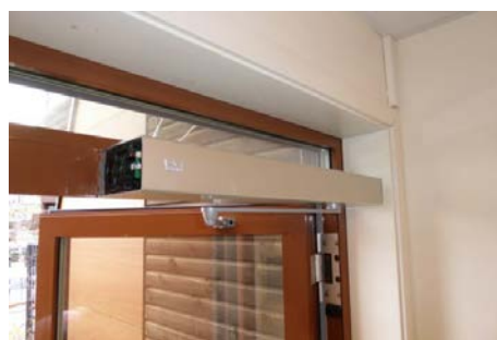
Bildet viser elektrisk dørpumpe.
