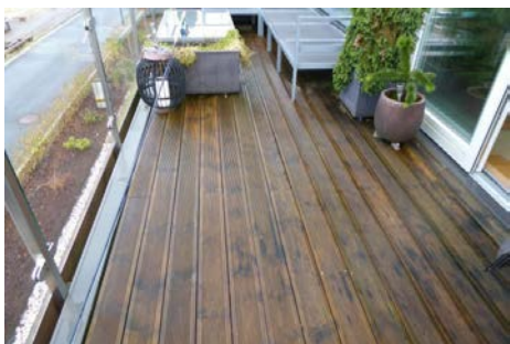
Tretremmegulv på terrasse 2. etasje.
