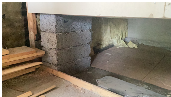
Fundamentering i garasje.
