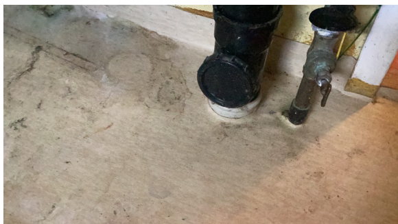
Stakepunkt i kjeller.
