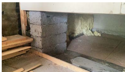
Fundamentering i garasje.
