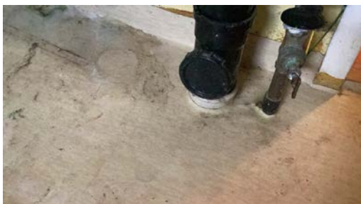
Stakepunkt i kjeller.
