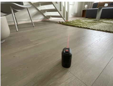
Nivellering stue, avvik ca. 10-20 mm
