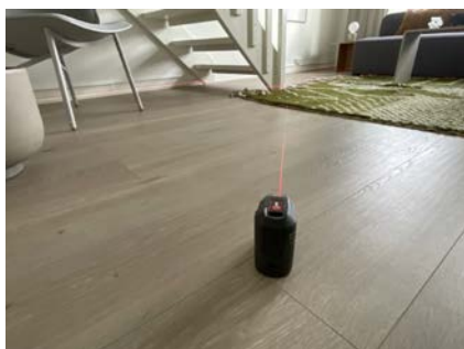
Nivellering stue, avvik ca. 10-20 mm
