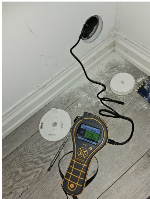
Bilde fra uktnmåling i utlektet veggkonstruksjon.
