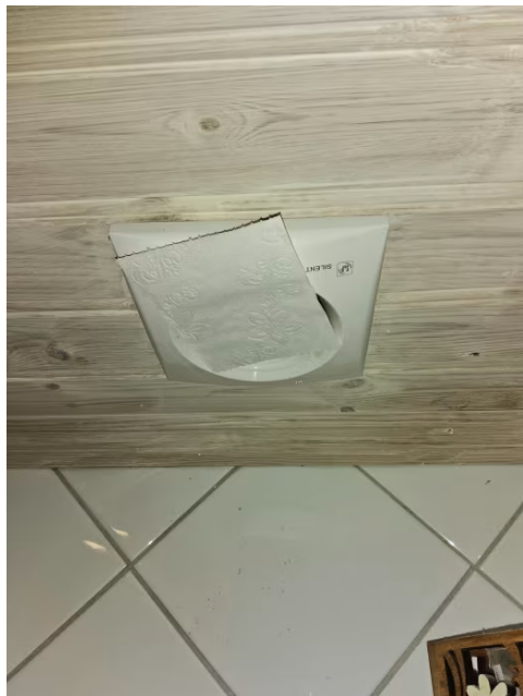
Avtrekksvifte er testet med papir.
