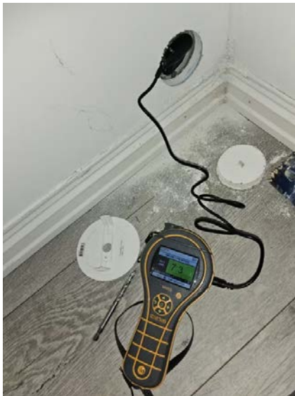
Bilde fra uktnmåling i utlektet veggkonstruksjon.
