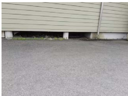
Boligen er oppført med grunnmur av betong og åpen fundamentering med betongsøyler.
