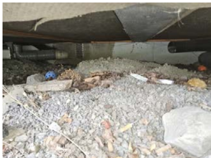
Åpent kryprom under deler av boligen.
