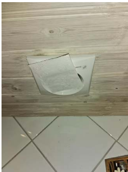
Avtrekksvifte er testet med papir.
