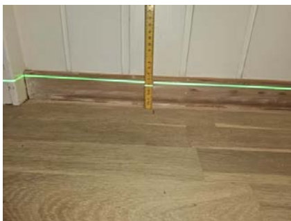
Etasjeskiller er kontrollert med nivelleringslaser.
