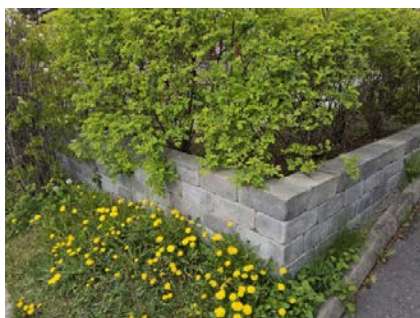
Støttemur av betongstein.
