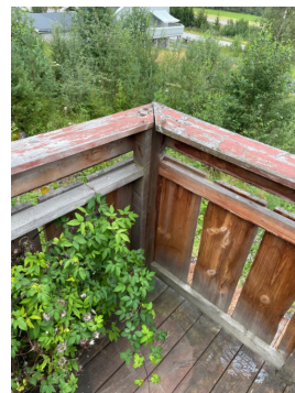
Synlig værslittasje og oppsprukket treverk.
