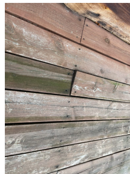
Synlig værslittasje og oppsprukket treverk.
