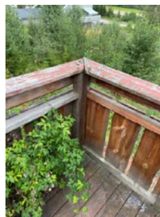
Synlig værslittasje og oppsprukket treverk.
