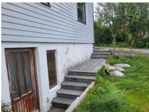
Manglende rekkverk.
