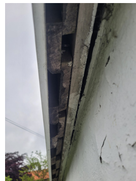
Montert direkte utenpå stående trepanel.
