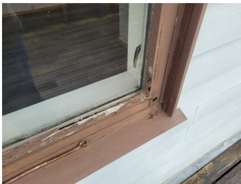
Forhøyet fuktnivå takvindu.
