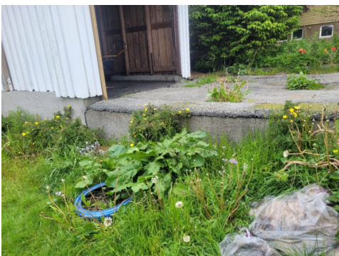
Manglende rekkverk.
