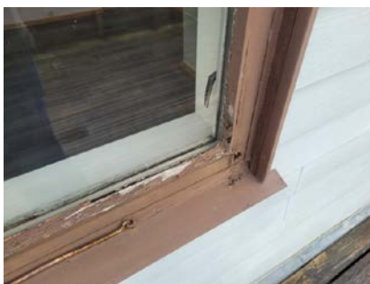
Forhøyet fuktnivå takvindu.
