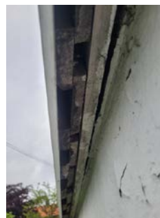
Montert direkte utenpå stående trepanel.
