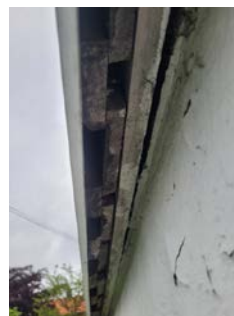
Montert direkte utenpå stående trepanel.
