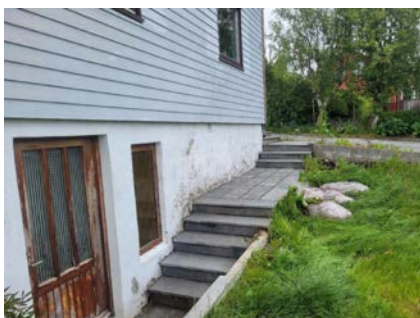
Manglende rekkverk.
