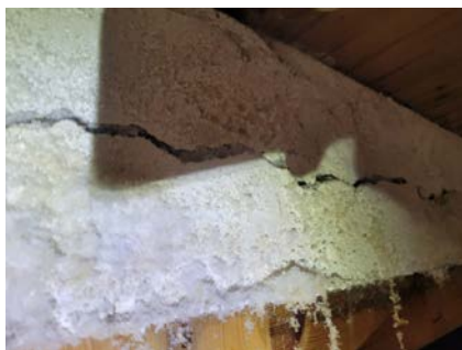
Sprekk i betongdrager og kalkutslag.
