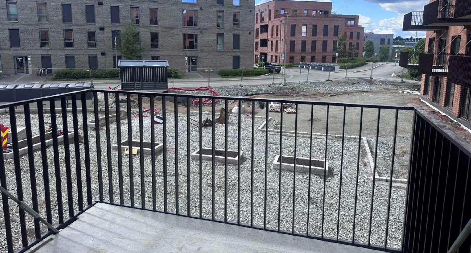
Trivelig balkong på ca. 7 kvm ut mot fellesarealet.
