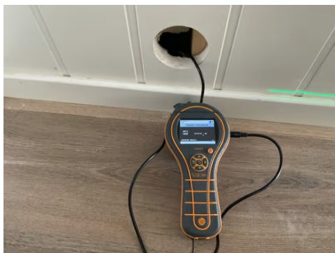
Hulltaking i tilstøtende rom.
