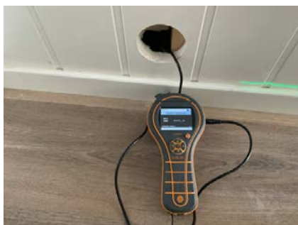
Hulltaking i tilstøtende rom.
