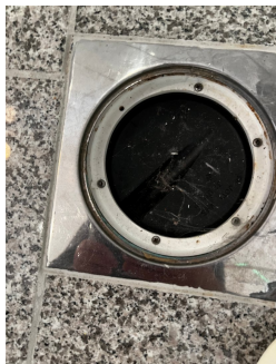
Hjelpesluk, mangler 1 skrue klemring
