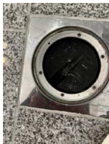
Hjelpesluk, mangler 1 skrue klemring
