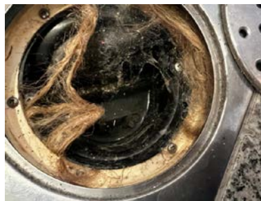
Sluk med hamp i under klemring
