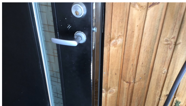
Slitasje merker på dør
