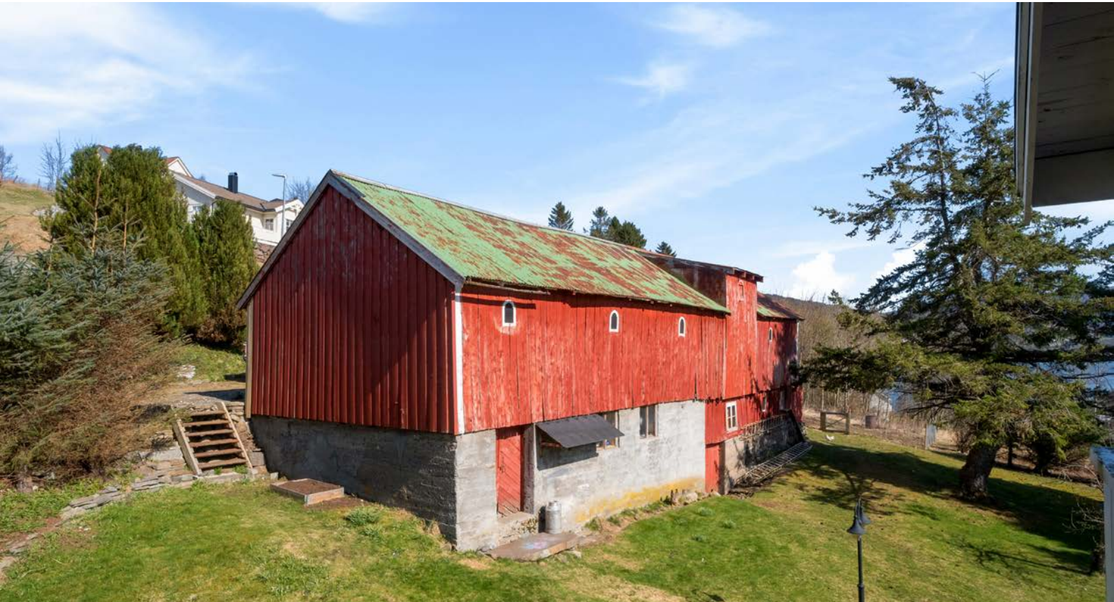
Driftsbygningen har eldre konstruksjon med vegger av stående bordkledning.
