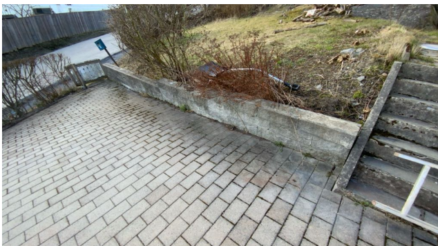
Besiktigelse av støttemur.
