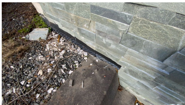
Kontroll av drenering/fuktsikring.
