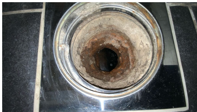
Kontroll av sluk.
