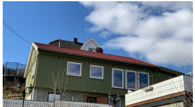
Besiktigelse av taktekke.
