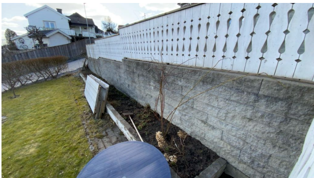
Besiktigelse av støttemur.
