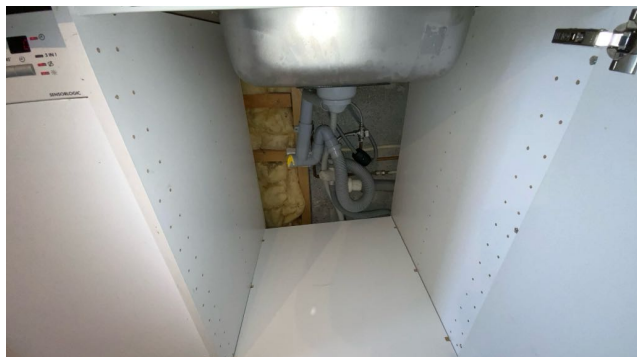
Besiktigelse av røropplegg.
