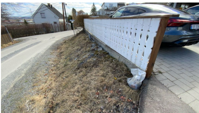
Besiktigelse av støttemur.
