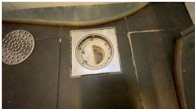
Kontroll av sluk.
