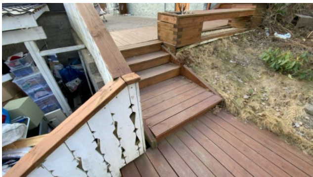
Besiktigelse av trapp.
