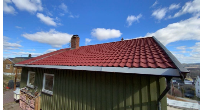
Besiktigelse av taktekke.
