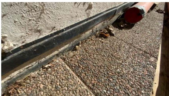
Kontroll av drenering/fuktsikring.
