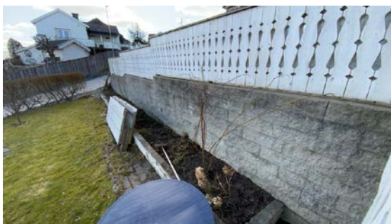
Besiktigelse av støttemur.
