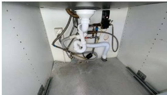
Besiktigelse av røropplegg.
