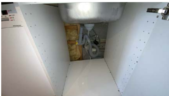
Besiktigelse av røropplegg.
