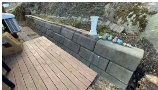
Besiktigelse av støttemur.
