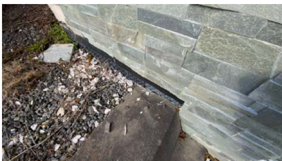
Kontroll av drenering/fuktsikring.
