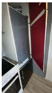
Kontroll bak ovn. Ingen tegn til fuktskader på befaringsdagen.
