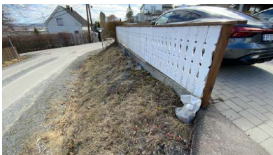
Besiktigelse av støttemur.
