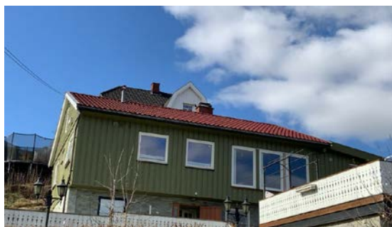
Besiktigelse av taktekinge.
