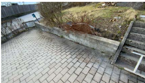
Besiktigelse av støttemur.
