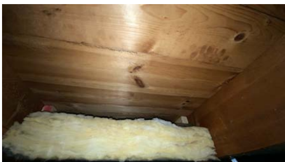
Synlige luftespalter på undertak.
