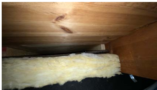
Synlige luftespalter på undertak.
