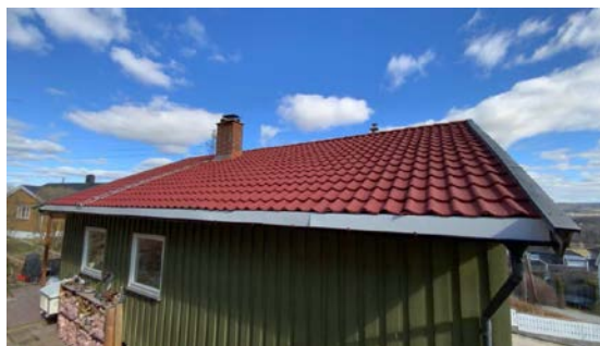
Besiktigelse av taktekinge.
