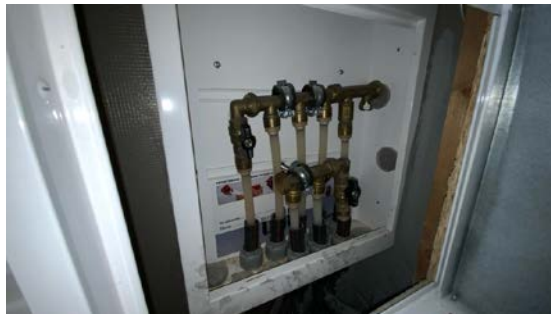
Besiktigelse av røropplegg.
