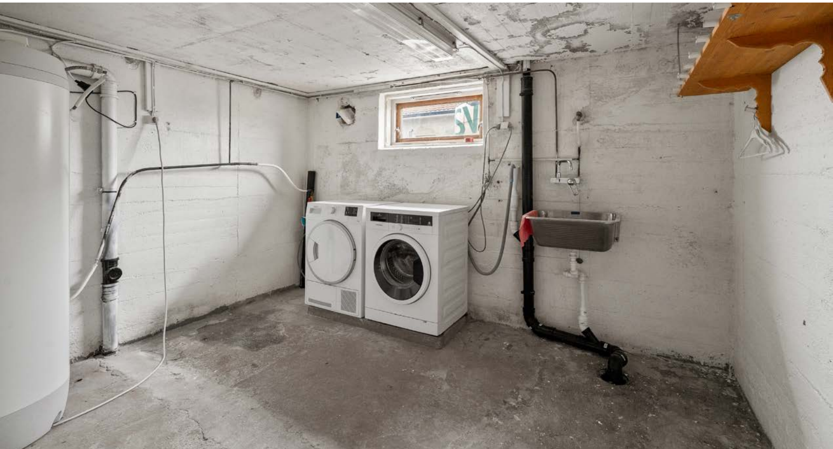
Vaskerommet i kjelleren har betongvegger og gulv, og er utstyrt med opplegg for vaskemaskin og tørketrommel.
