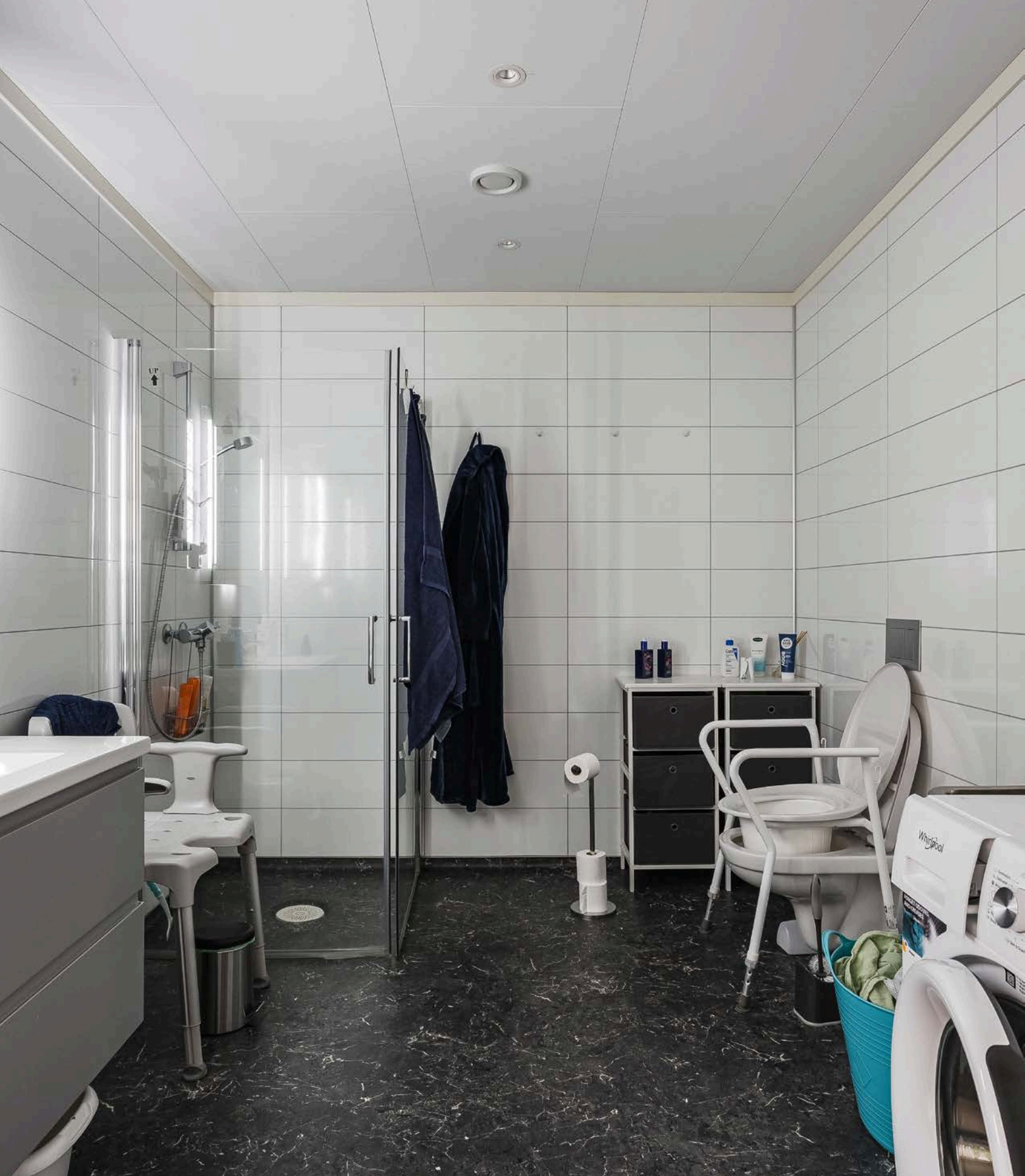
Lyst og moderne badrom fra 2020 med belegg på gulv med gulvvarme, våtromsplater på veggene, downlights i himlingen og balansert ventilasjon.
