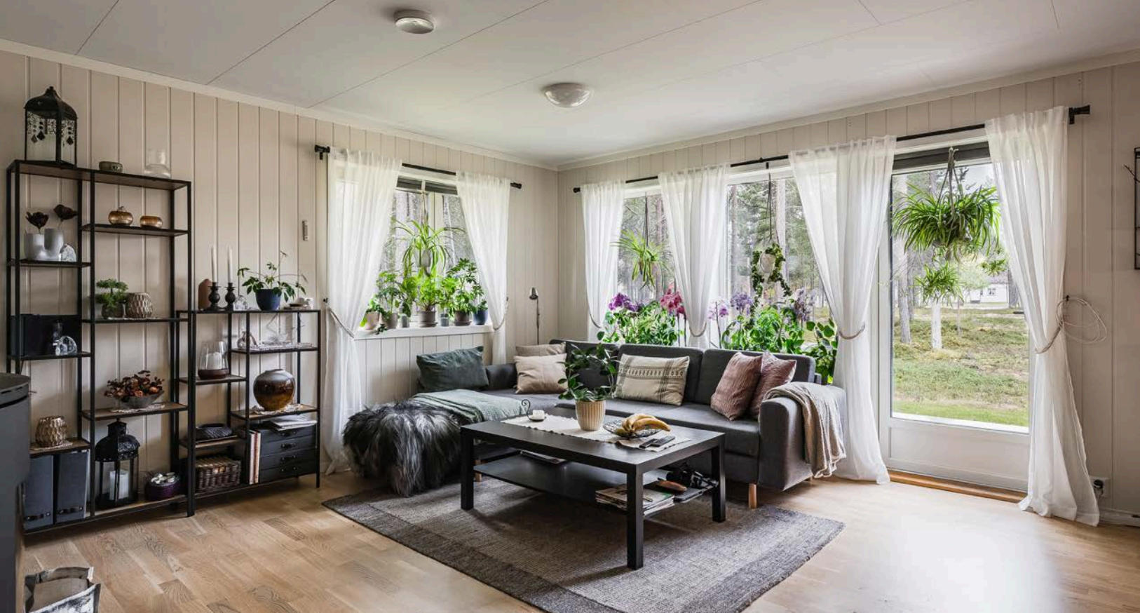
Stuen har god standard med laminat på gulv, lyse panelplater på veggene og skjult elektrisk anlegg.
