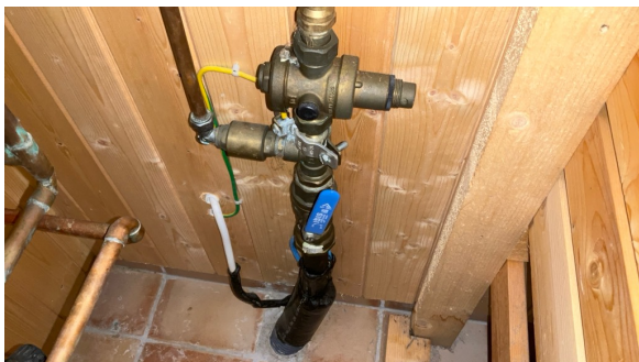
Stoppekran og vannmåler.
