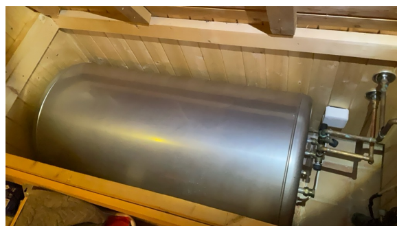
Varmtvannsbereder
