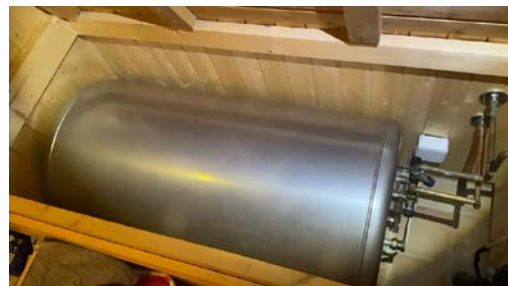
Varmtvannsbereider
