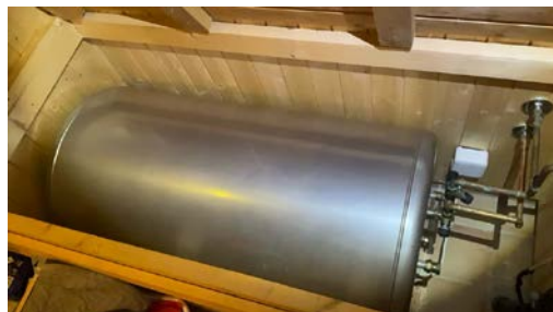
Varmtvannsbereider
