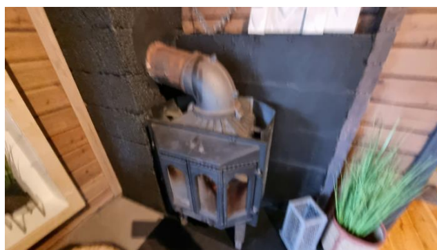
Det gjenstår arbeider rundt peisinsatsen.
