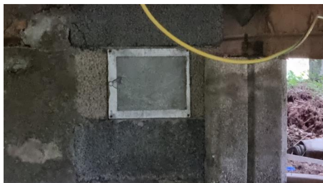
Kontroll av sotluke.
