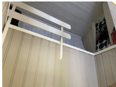
Rekkverk/topp av trappeløp.
