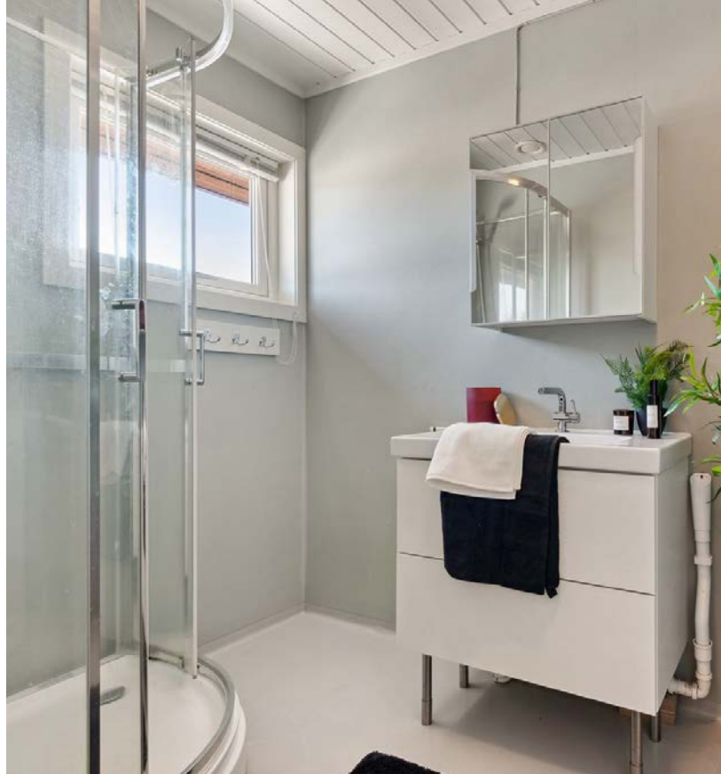
Baderom innredet med dusjkabinett, servant på innredning og skap med speil. Vinylbelegg på veggene.
