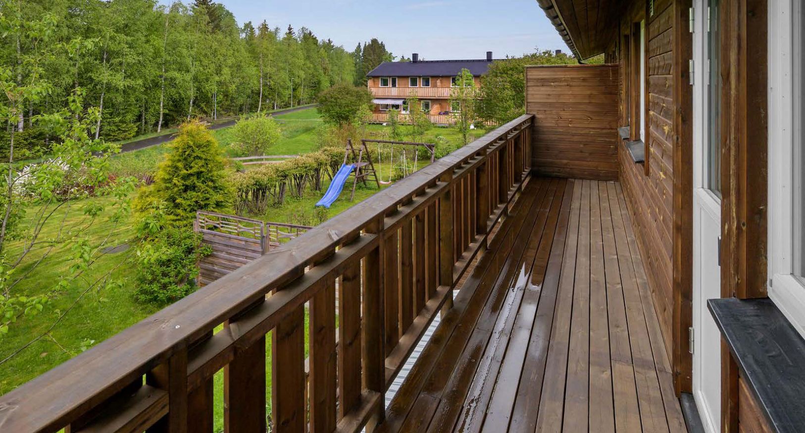
Balkongen i 2. etasje med utsyn over lekeområdet og skogen. Levegg mot naboer.
