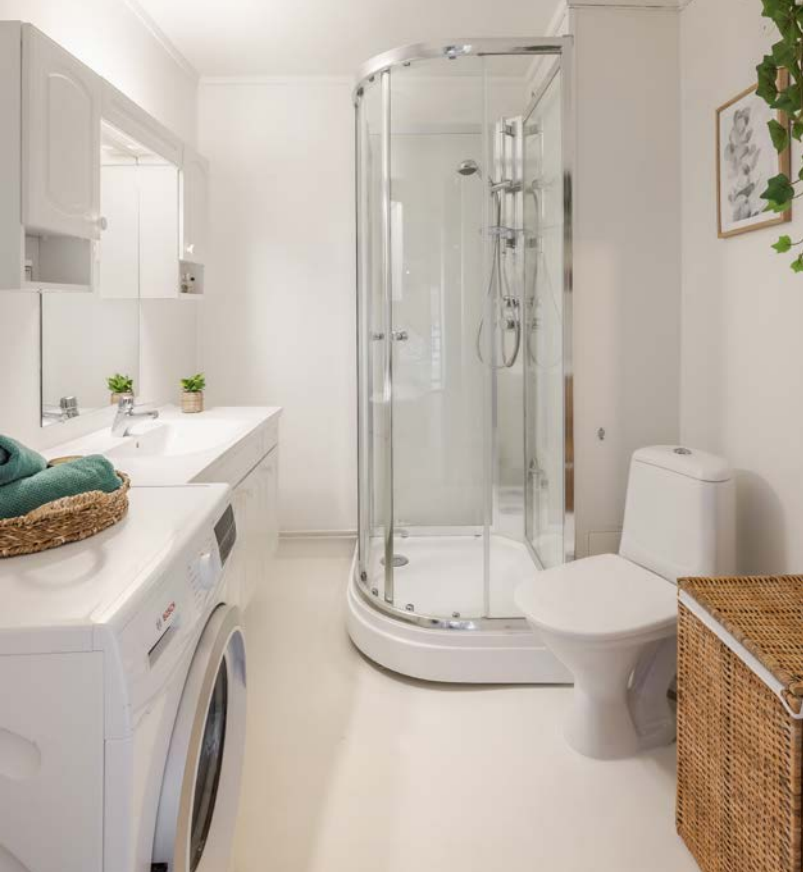
Lyst bad med malt vinylbelegg på gulv og vegger. Badet har gulvmontert toalett, dusjkabinett og opplegg for vaskemaskin.
