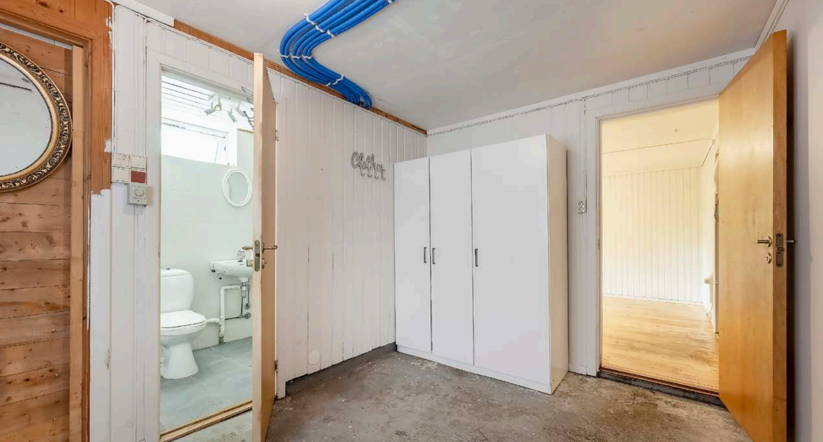
Vindfang/gang i underetasje
