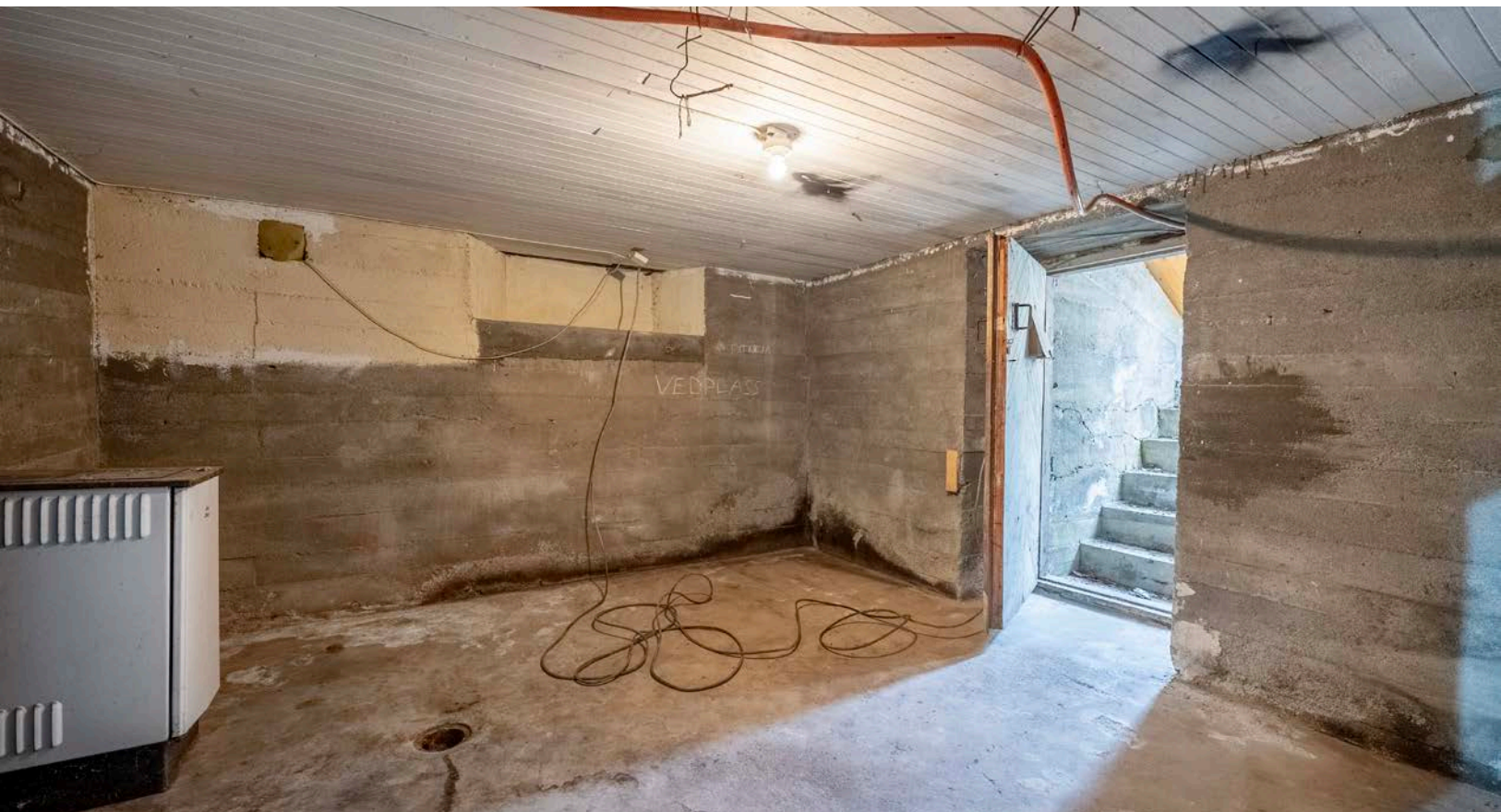
Kjellerrom med vedovn og inngang via utvendig trapp med lem
