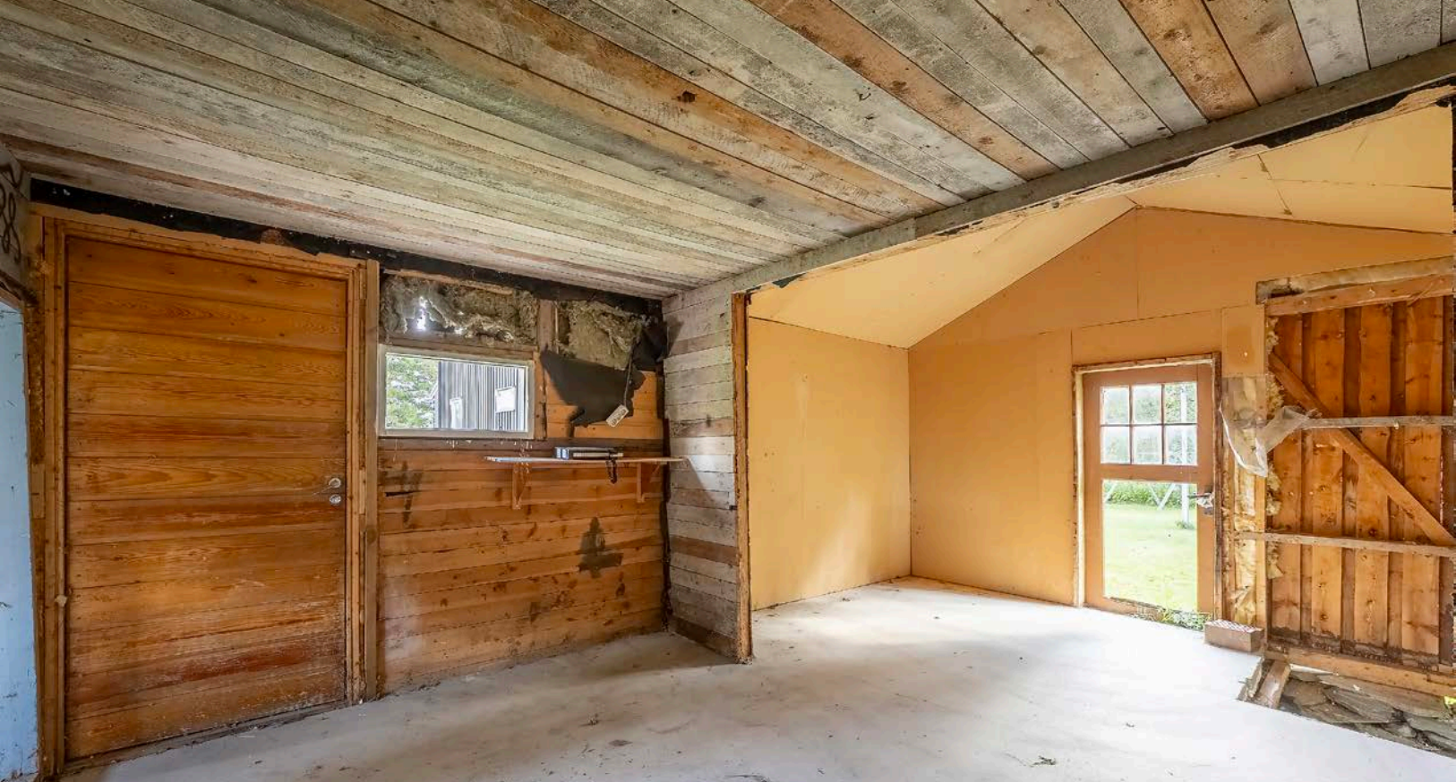
Uthus med lagerrom
