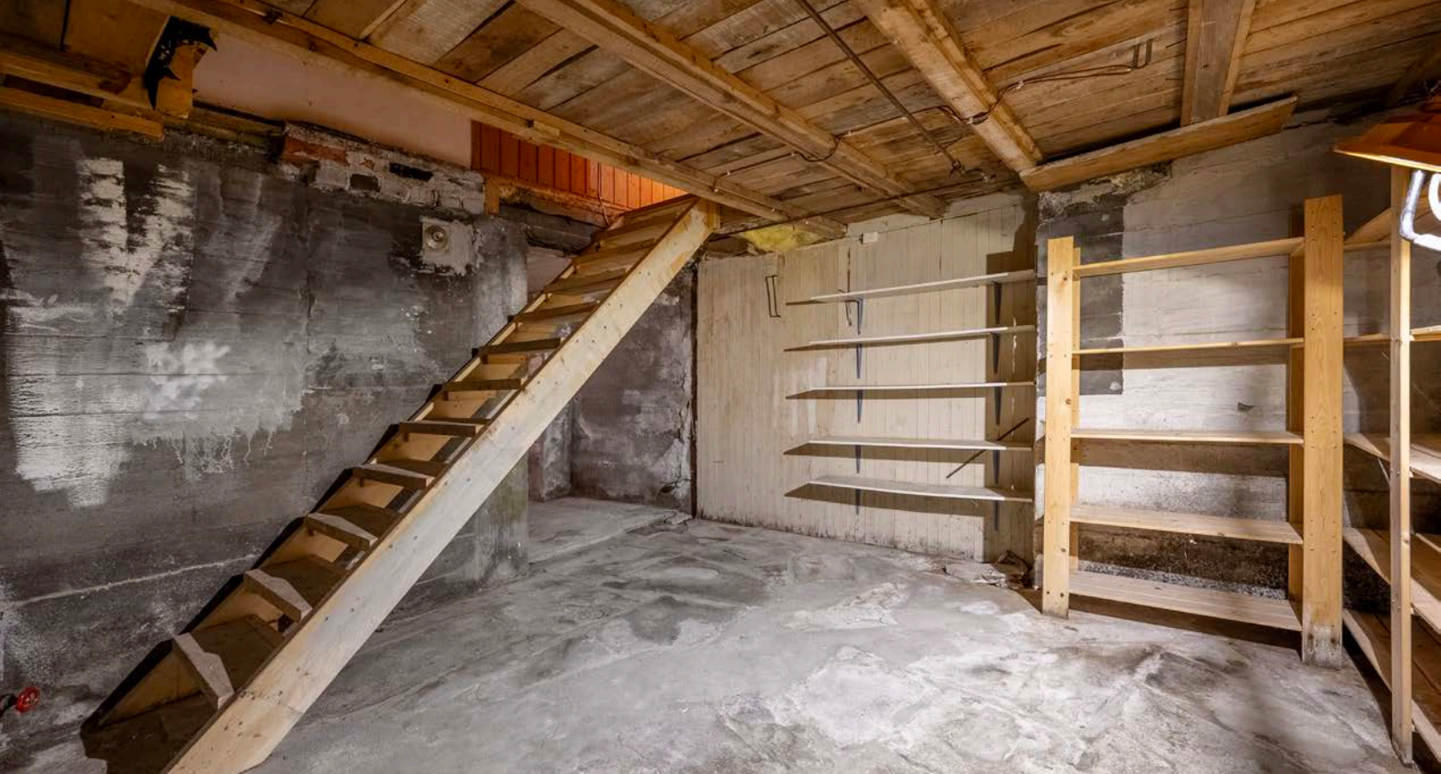
Kjellerrom med trapp til 1. etasje
