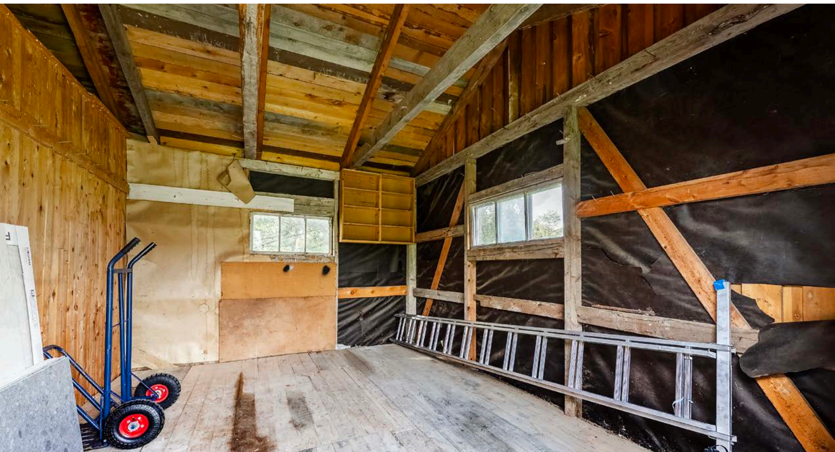
Uthus med lagerrom
