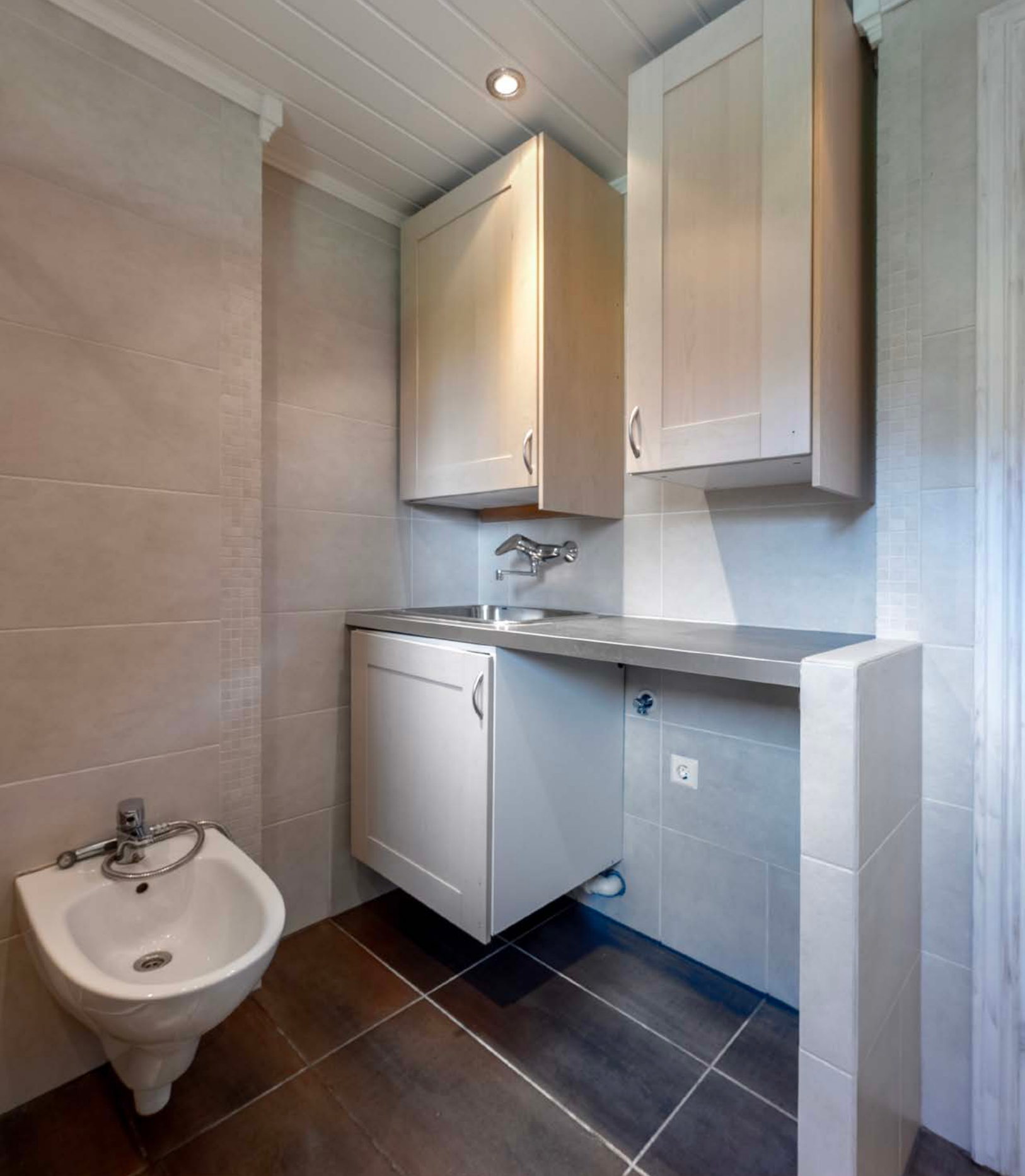
Bad med vaskeromsinnredning
