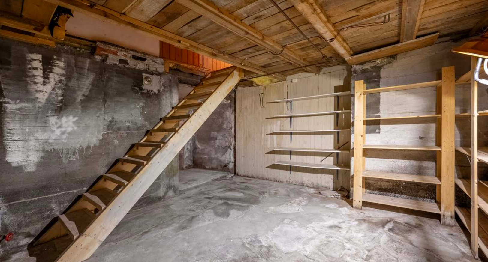
Kjellerrom med trapp til 1. etasje
