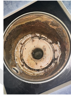
Hovedsluk med klemring for membran
