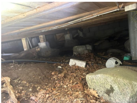
Krypekjeller, utluftet del.
