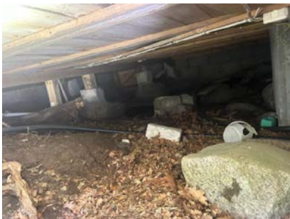
Krypekjeller, utluftet del.
