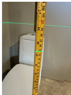
80cm ut fra sluk 94,9cm, lokalt fall på 4mm.
