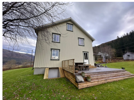
Trapp/terrasse mot sør
