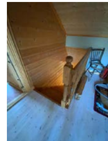
Åpning på 15cm mellom trinn.
