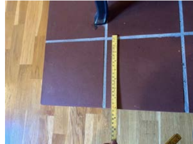
Flis under ovn dekker kun 20cm, krav er 30cm.
