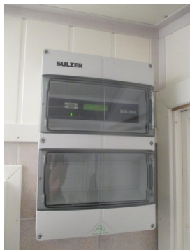
Styringsenhet for pumpe i utevendig bod.
