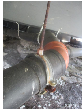
Deler av avløpsrør under hytta.
