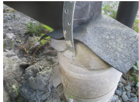
Pilar og drager på ytterhjørne av utvendig bod.
