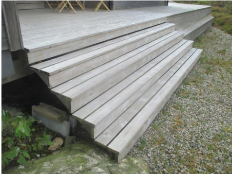
Bred trapp til terrasse ved inngangsparti.
