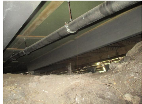
Deler av fundamenteringen.
