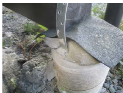
Pilar og drager på ytterhjørne av utvendig bod.
