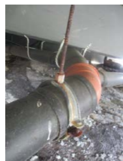
Deler av avløpsrør under hytta.
