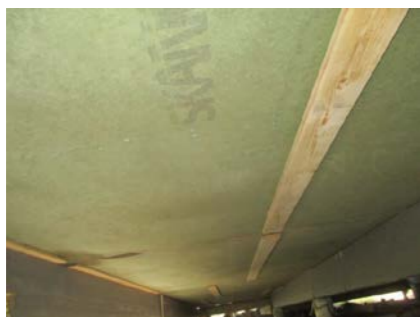
Deler av stubbloftet av større plater.
