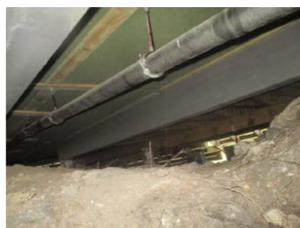
Deler av fundamenteringen.
