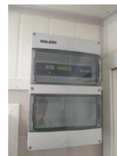
Styringsenhet for pumpe i utevendig bod.
