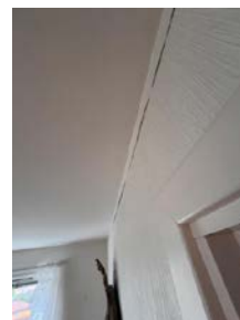
Glipper mellom taklist og vegg.
