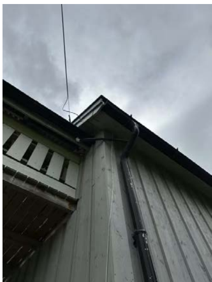
Det registreres ufagmessig tilkobling av takrenne ved balkong på begge sider.
