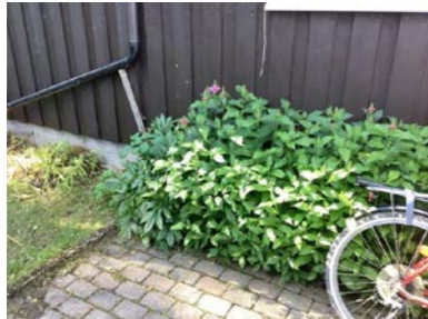
Beplantning inntil kledning anbefales fjernet.
