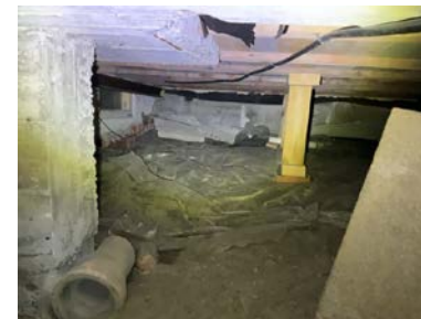
Kryperom fremstod som tørt og luftig på befaringsdagen.
