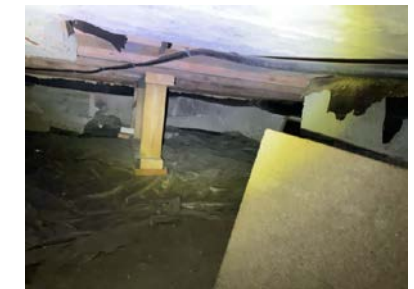
Kryperom fremstod som tørt og luftig på befaringsdagen.
