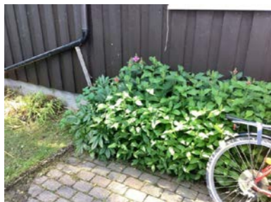
Beplantning inntil kledning anbefales fjernet.
