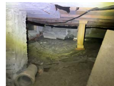
Kryperom fremstod som tørt og luftig på befaringdagen.
