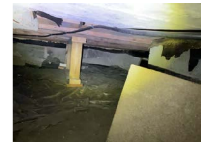
Kryperom fremstod som tørt og luftig på befaringdagen.
