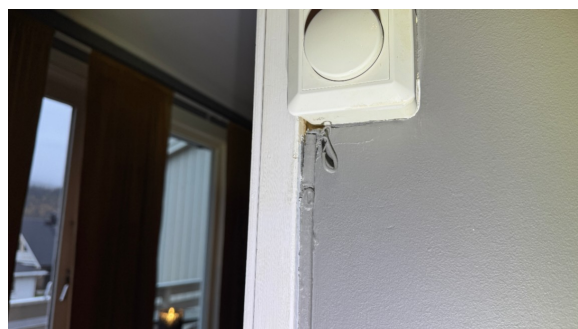
El-kabel er frakoblet.
