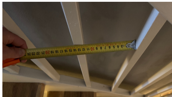
Kontroll av åpninger i rekkverk.
