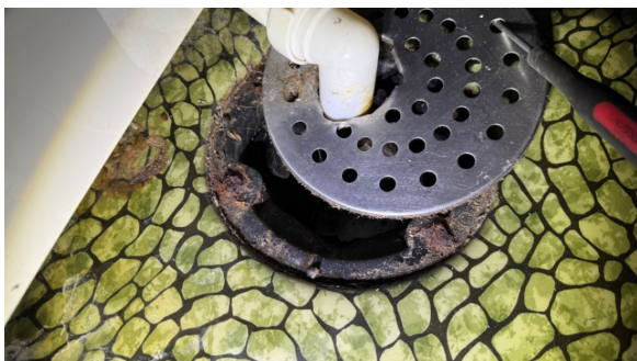
Kontroll av sluk.
