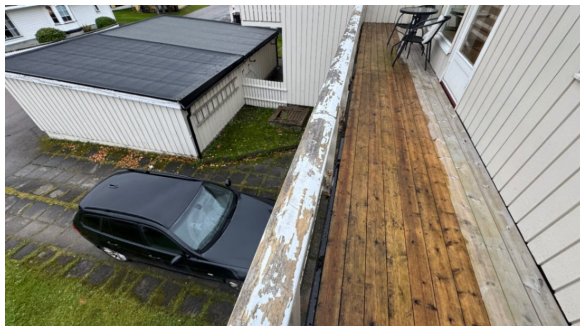
Værslitt rekkverk.
