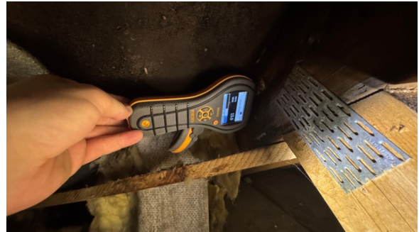
Ingen forhøyede fuktverdier ble registrert ved befarings.
