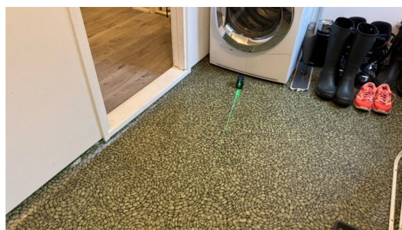
Kontroll av fallforhold.
