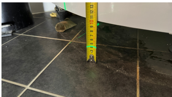
Kontroll av fallforhold.
