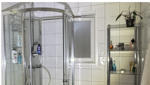
Vindu plassert i våtsone.
