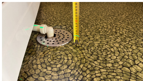
Kontroll av fallforhold.
