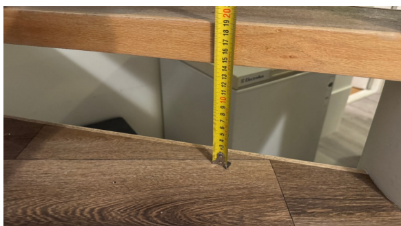
Åpninger mellom trinn i innvendig trapp er større enn dagens forskriftskrav.
