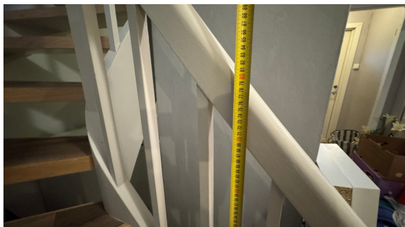
Kontroll av rekkverkshøyde.
