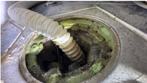
Kontroll av sluk.
