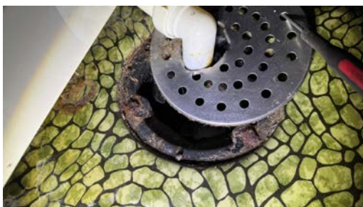
Kontroll av sluk.
