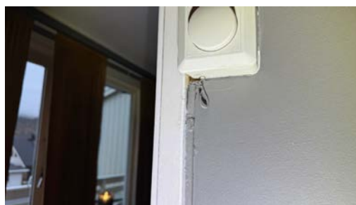
El-kabel er frakoblet.
