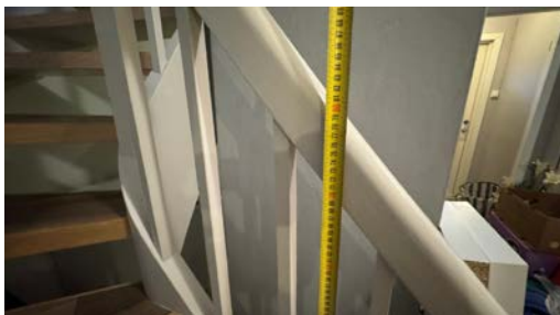
Kontroll av rekkverkshøyde.
