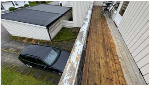
Værslitt rekkverk.
