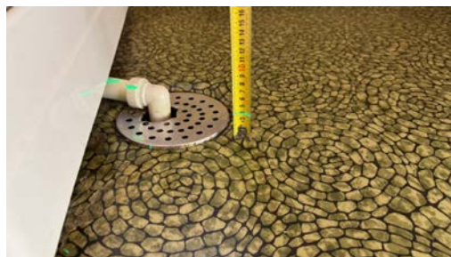
Kontroll av fallforhold.
