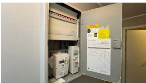
Kontroll av el-skap og kursfortegnelse.
