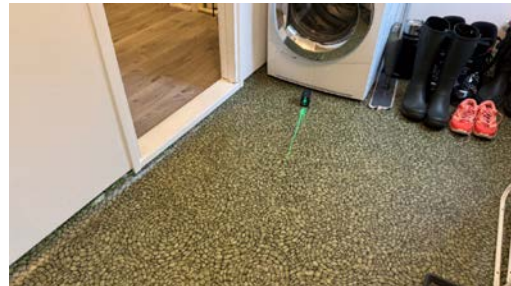
Kontroll av fallforhold.
