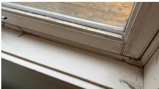
Det er påvist tegn på innvendig kondensering av enkelte vindusglass.
