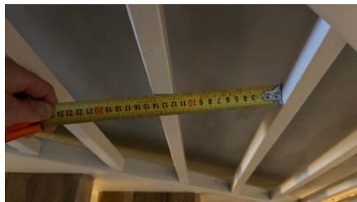
Kontroll av åpninger i rekkverk.
