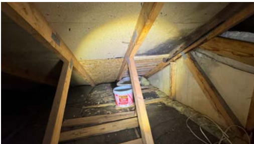
Deler av taktroen er skiftet i forbindelse med utbedring av en tidligere lekkasje.
