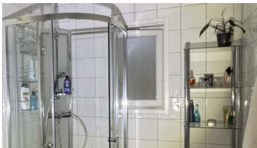
Vindu plassert i våtsone.
