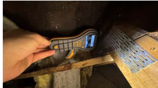
Ingen forhøyede fuktverdier ble registrert ved befarings.
