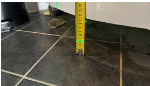
Kontroll av fallforhold.
