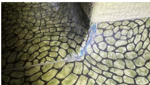
Utettheter i gulvbelegg.
