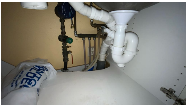
Besiktigelse av røropplegg.
