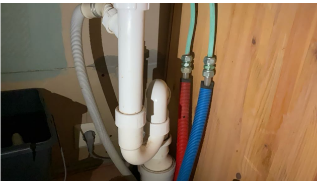
Synlige rør under kjøkkenbenken.
